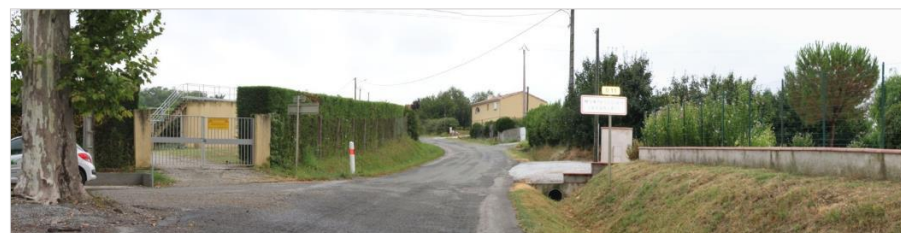
Entrée Nord-Est, matérialisée Source : L'Artifex
