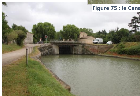
Figure 76 : Ensemble éclusier de la Négra Source l'Artifex
