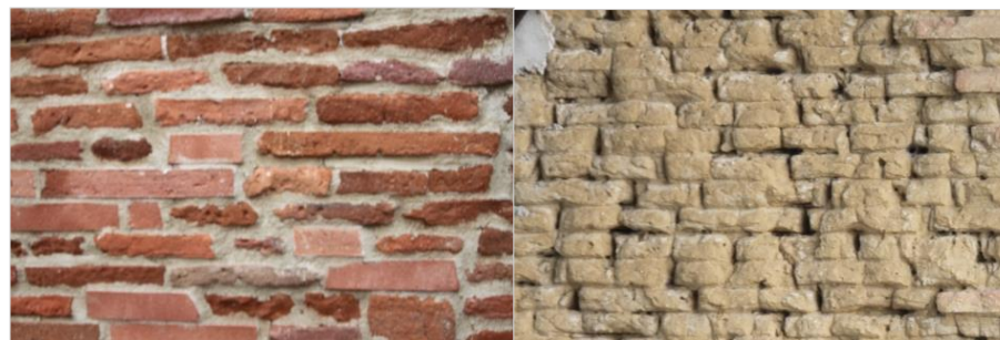
Façade en Brique cuite à la chaux Source : L'Artifex
